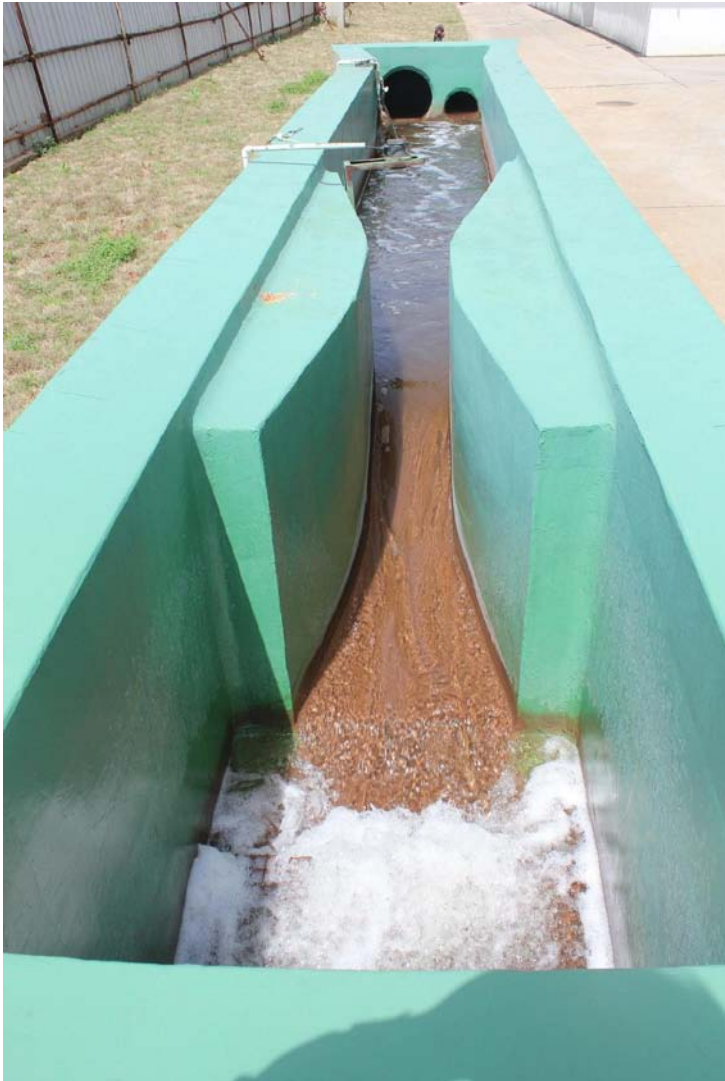
图表 11 生产废水总排放口
