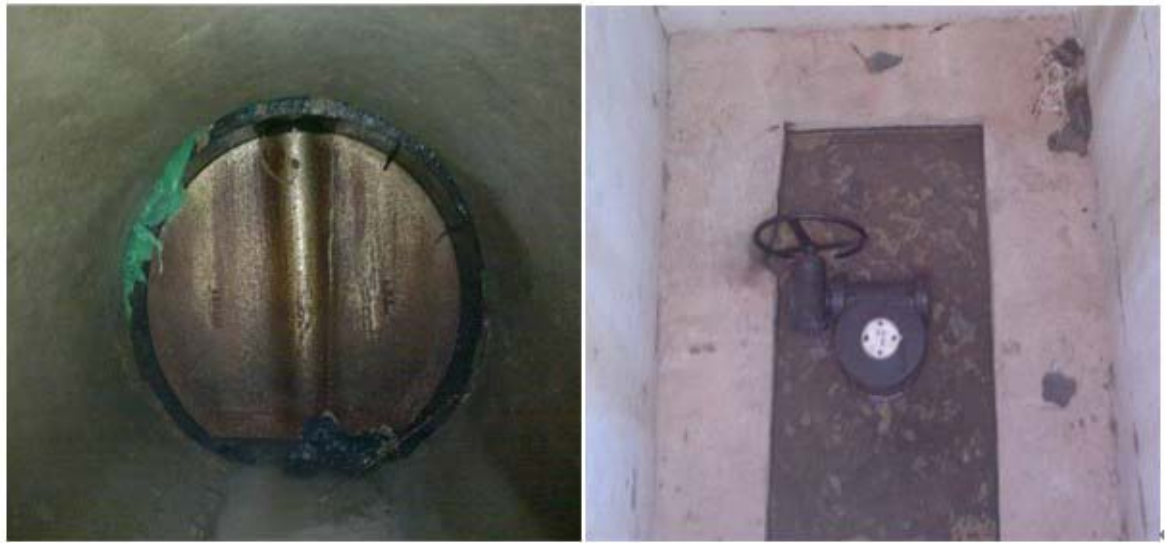
图表 8 雨水口铅封图片
