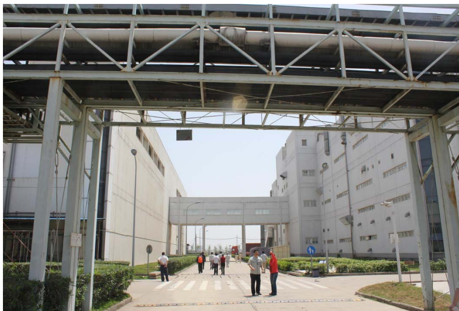
图表 7 为避免污水和雨水管网混搭的情况，将原地下工业废水输送管道改为地上
