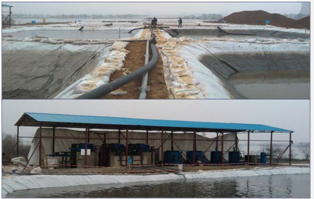
图表 13 南太子湖疏浚现场图--6个沉淀池
