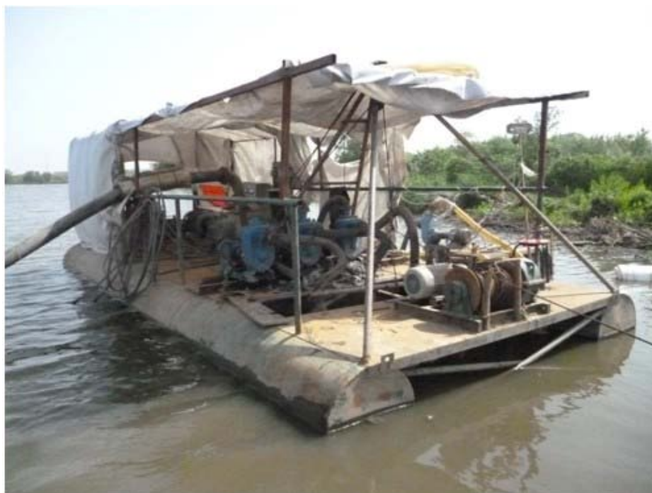
图表 14 南太子湖疏浚现场图--离心式脱水机组
