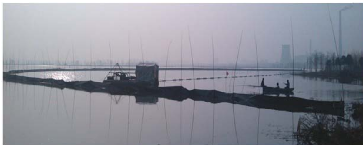
图表 15 南太子湖疏浚现场图--一艘简易清淤船+吸泥泵
